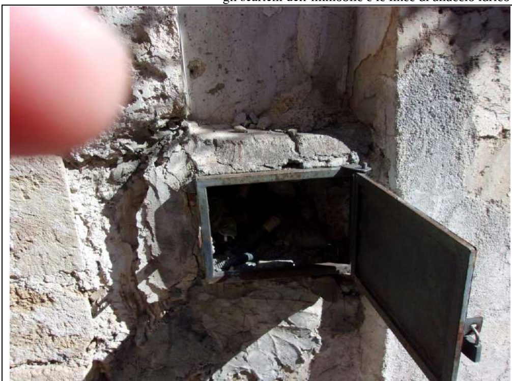
predisposizione contatore idrico
