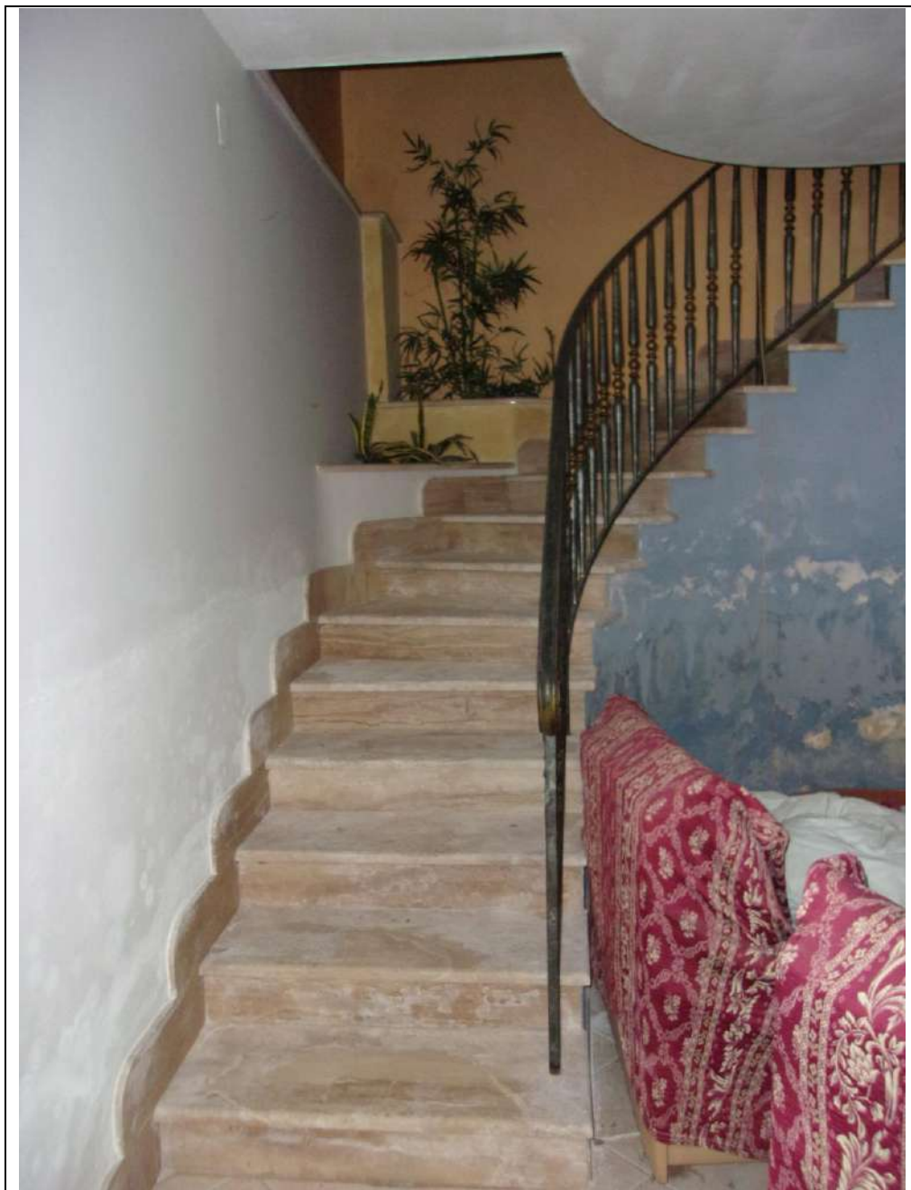
Scala di accesso al superiore ammezzato-primο piano
