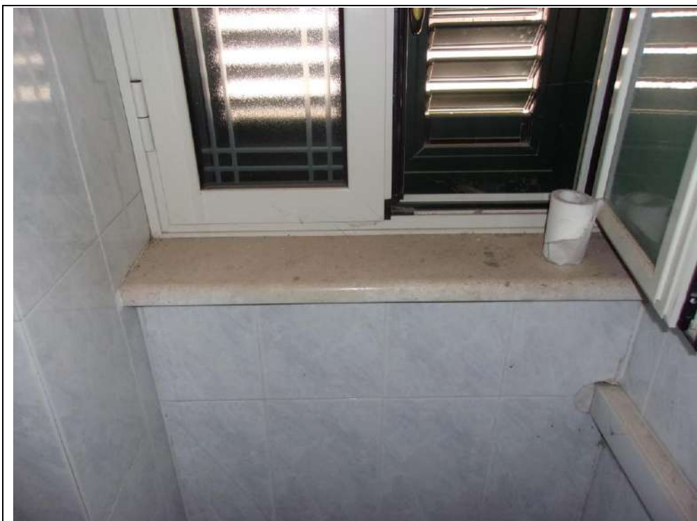
Tipologia di infissi eterni ammezzato-primο piano
