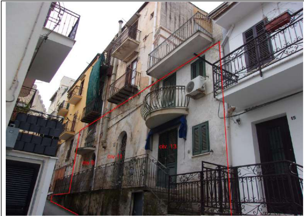
prospetto dell'intero immobile su Via Ludovico Ariosto
