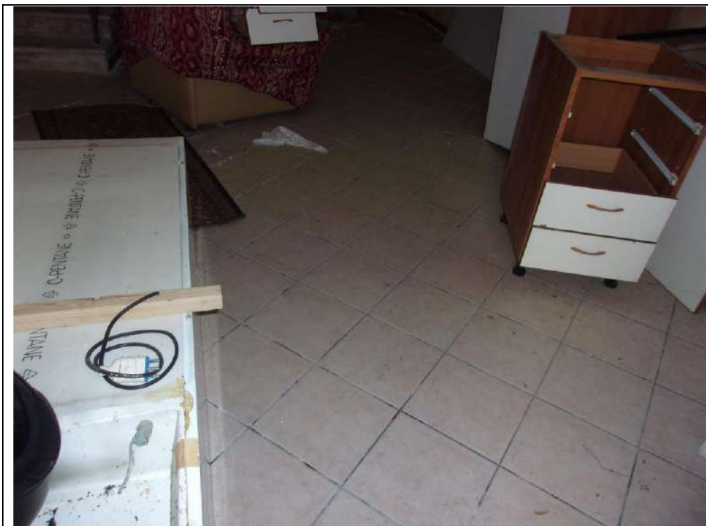
pavimentazione –piano terra
