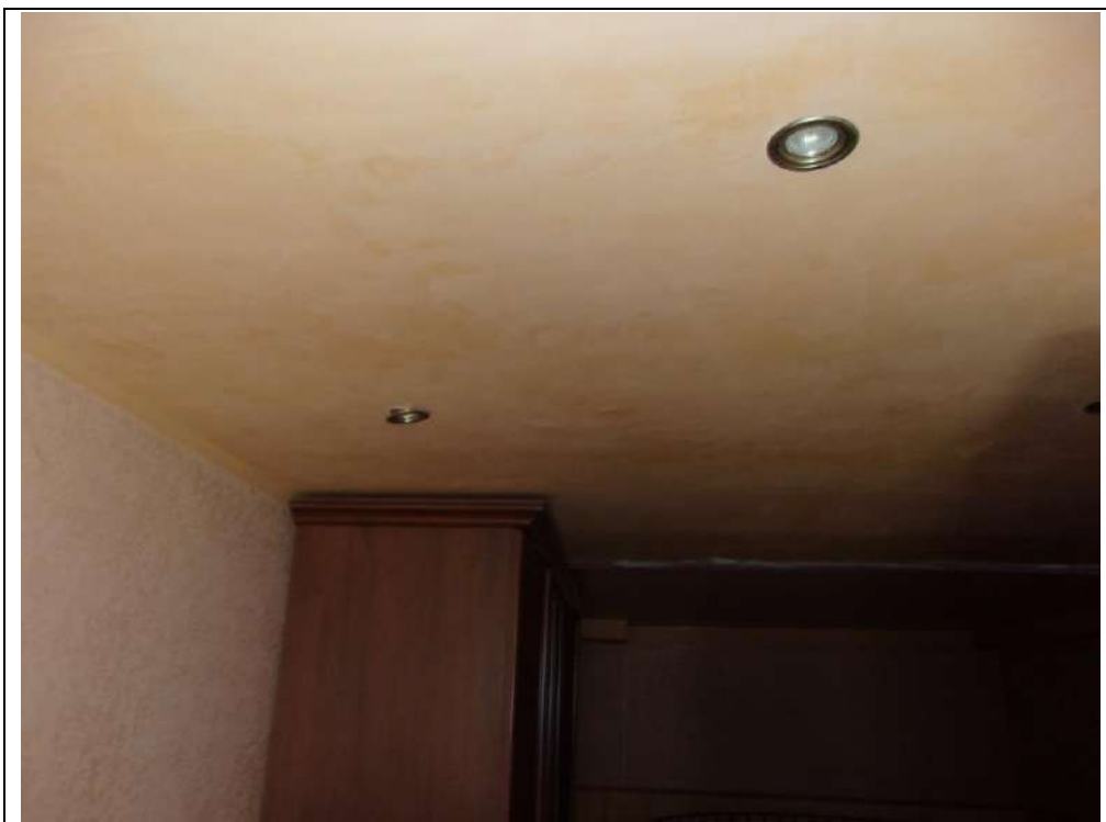
Camera da letto controsoffitto
