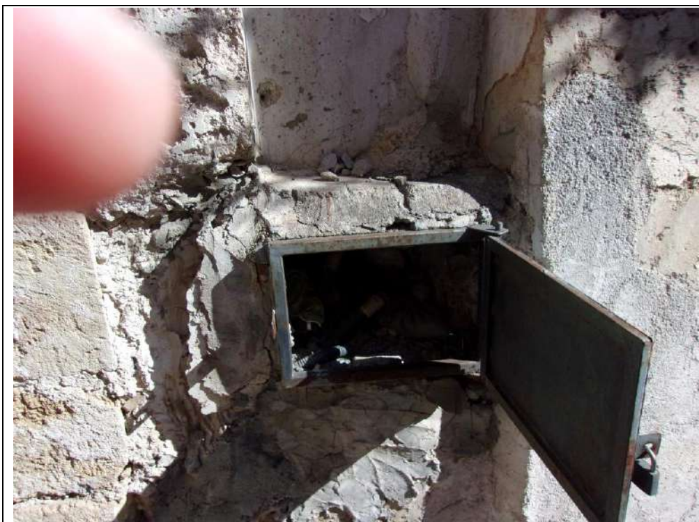
predisposizione contatore idrico
