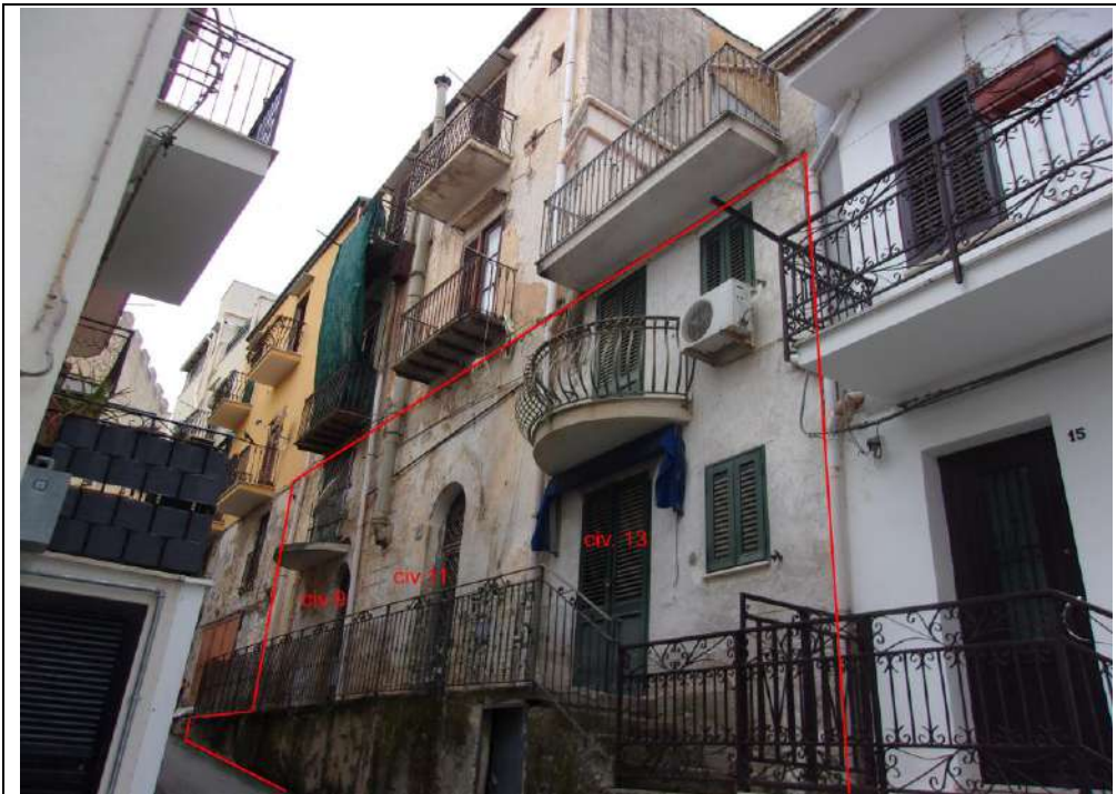
prospetto dell'intero immobile su Via Ludovico Ariosto
