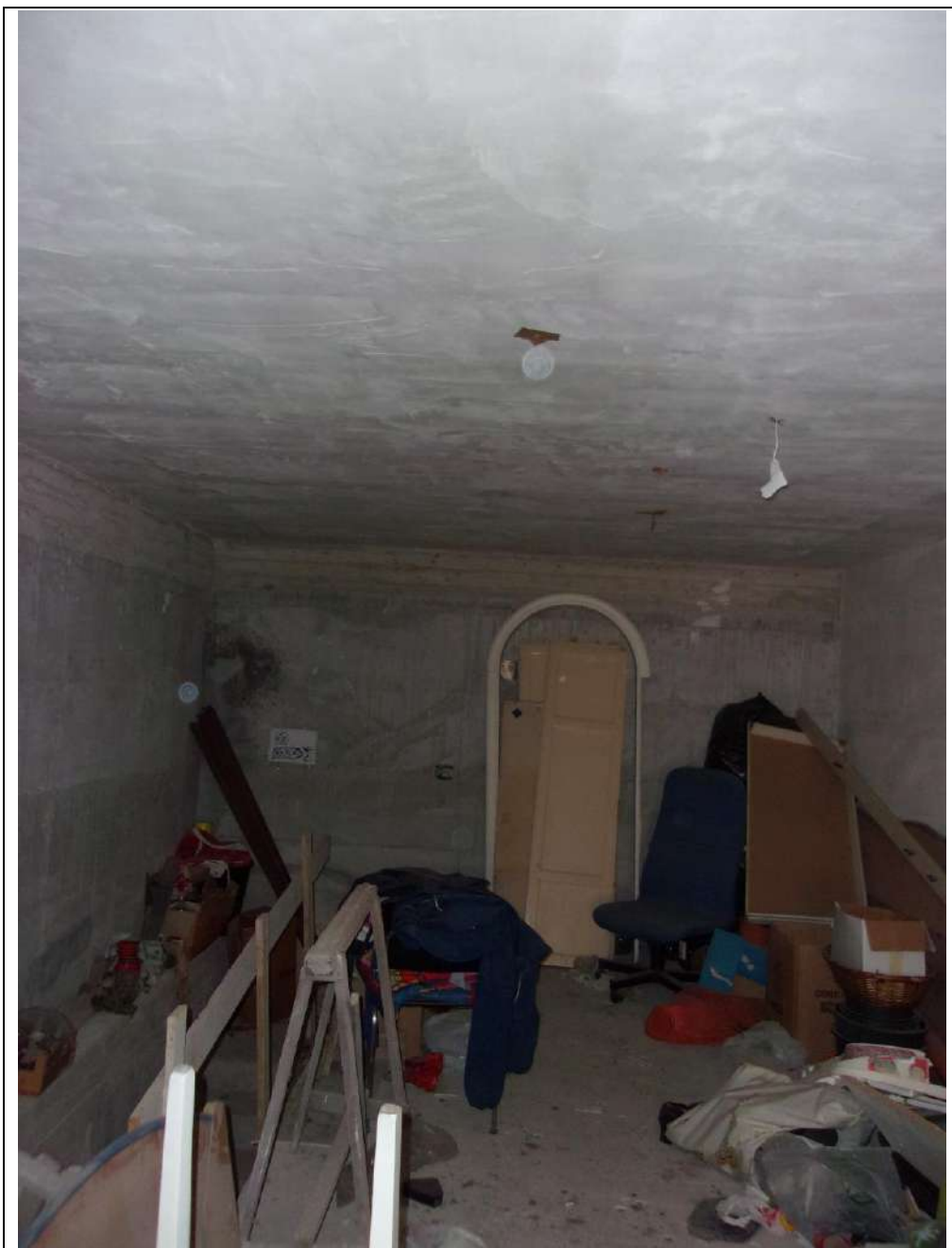
al piano superiore deposito
