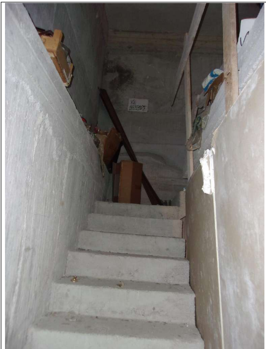
scala di accesso al piano superiore
