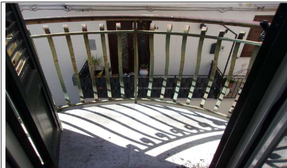
Balcone ammezzato-primο piano
