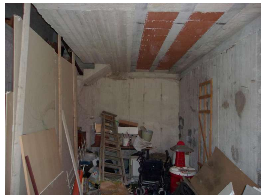
piano terra magazzino deposito
