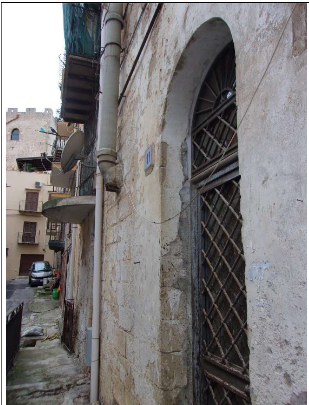
ingresso civico 11 appartamento
