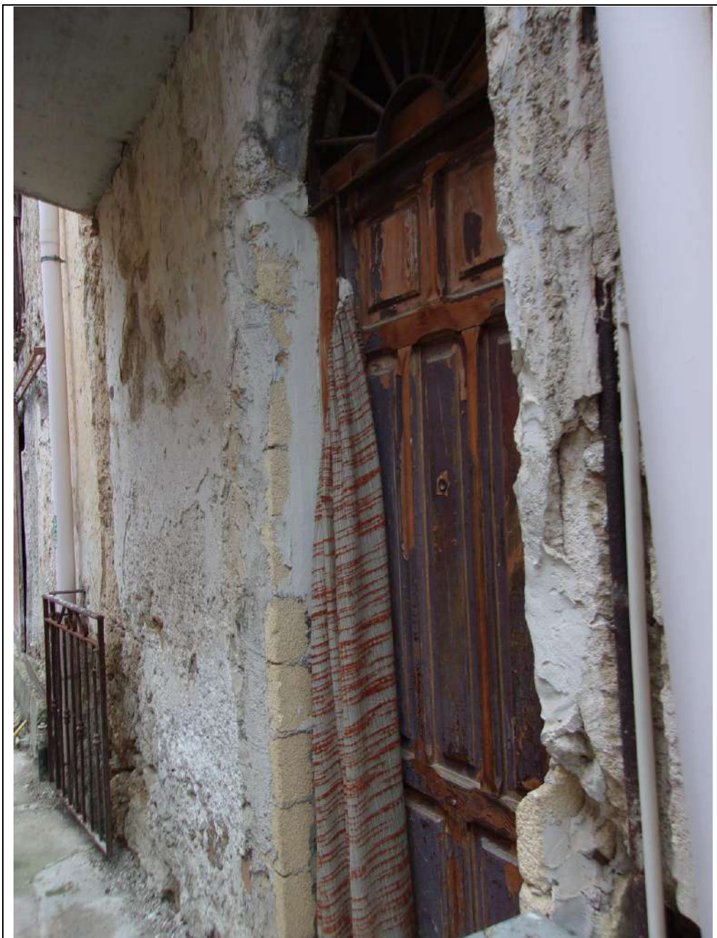
ingresso civico 9 magazzino deposito
