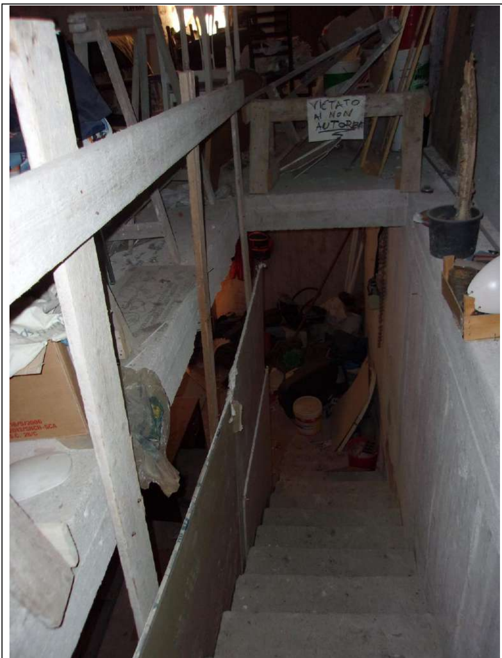
scala di accesso al piano superiore
