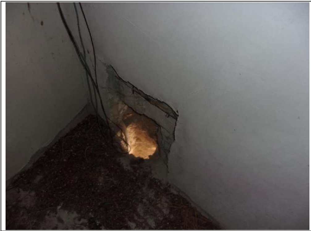
piano superiore deposito Scavo per predisposizione nuovi impianti
