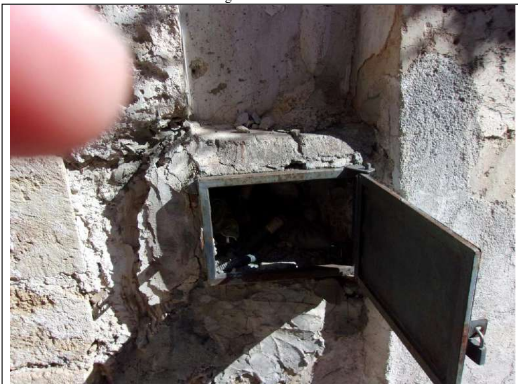
predisposizione contatore idrico
