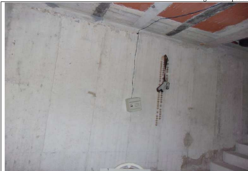
piano terra magazzino deposito
