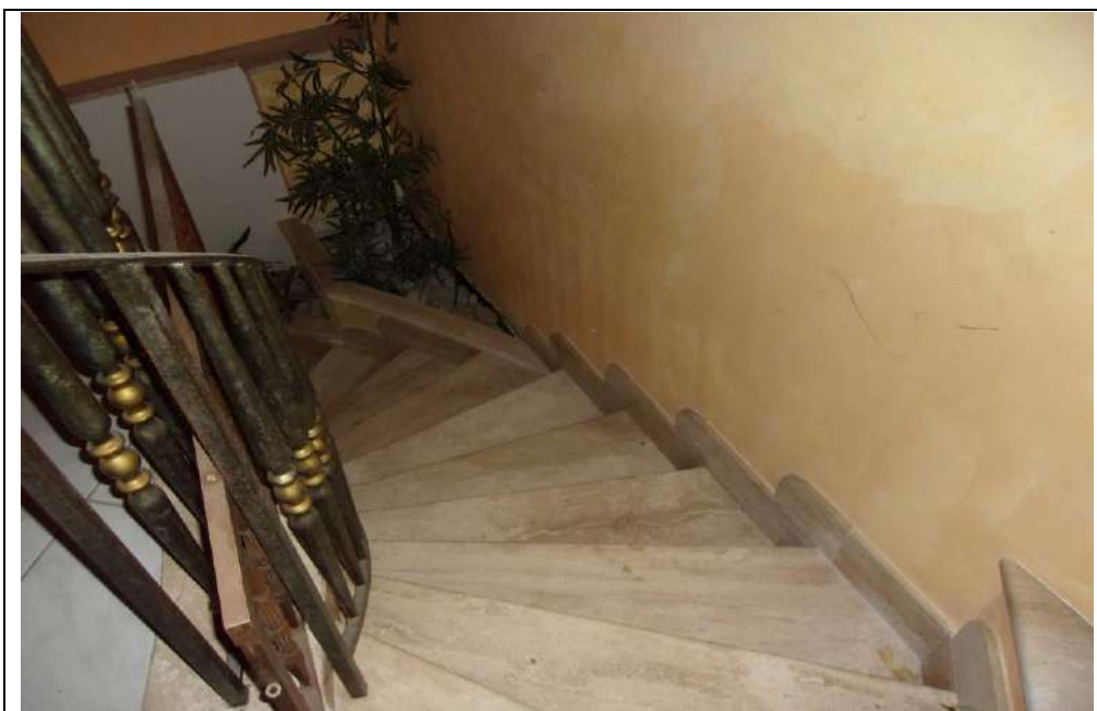
Scala di accesso al superiore ammezzato-primo piano
